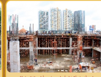
Hoàn thiện phần móng, chuẩn bị đổ sàn tầng 1
