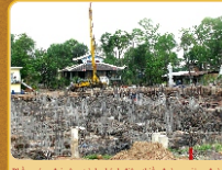
Phần móng đại công trình chánh điện, thiền đường, giảng đường
