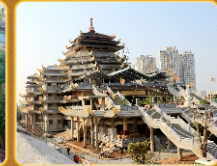
Chánh điện đang dần hoàn thiện
